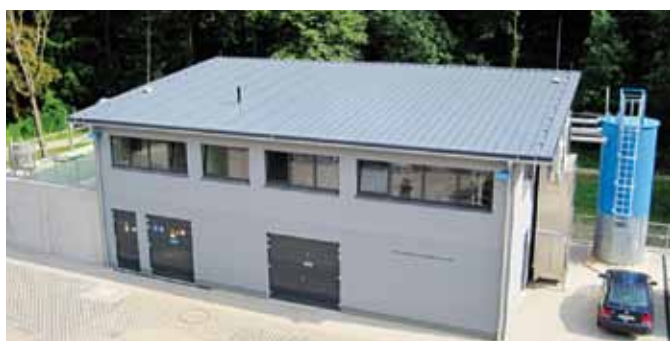
Het ziekenhuisafvalwaterzuiveringsstation van het Duitse waterschap Emschergenossenschaft in het Marienhospital Gelsenkirchen (D)
