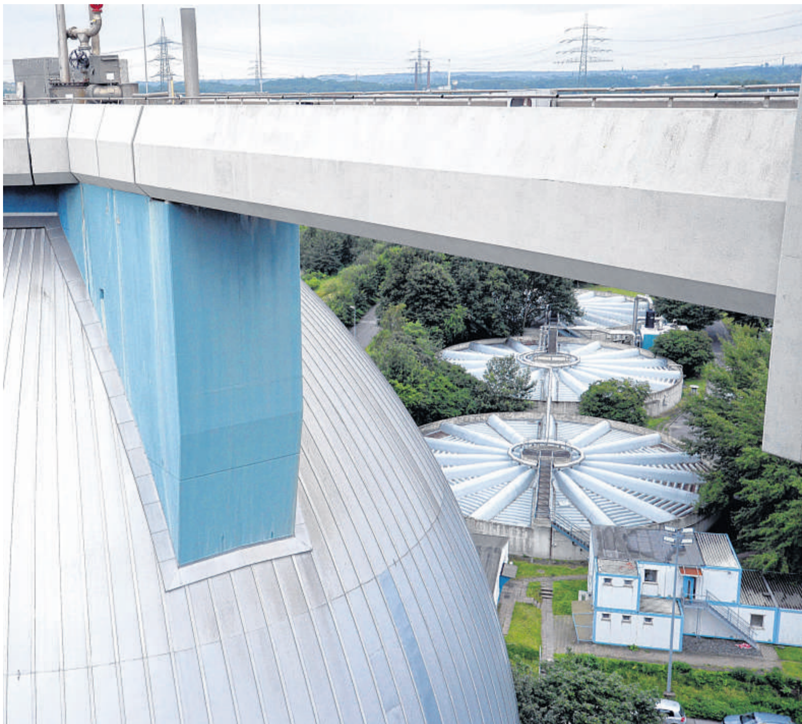
Großanlagen wie die in Bottrop mussten unter erheblichem Aufwand umgebaut werden, um den Großteil an Arzneimitteln aus dem Abwasser zu filtern.
