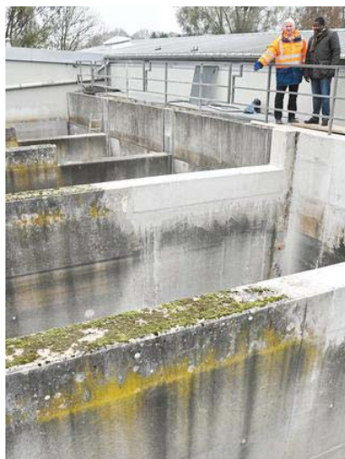
In den beiden vorderen Becken wird demnächst das Abwasser mit der Aktivkohle vermischt, erläutern Helmut Wissing (l.) und Dr. Issa Nafo. Foto: Kerstan
